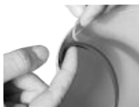
Installation der Dichtung
